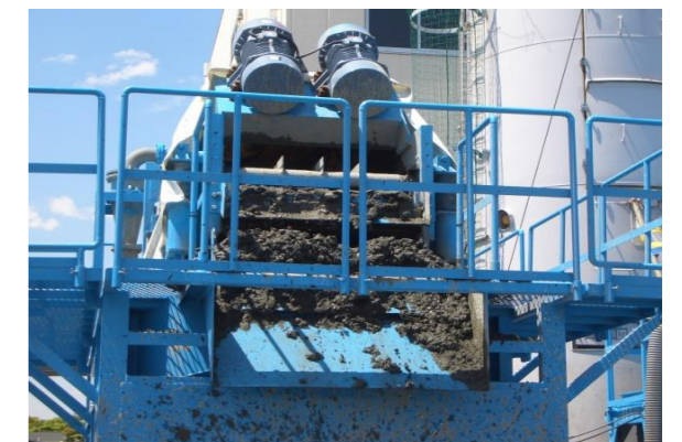
⑤KGソイル分離機からの排出土
