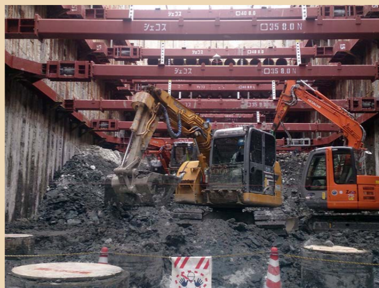
道路函渠工事
