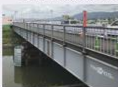
用途: 迂回路用仮橋 橋長・幅員: 40m x 14m 発注者: 国土交通省 施工地: 京都府亀岡市
