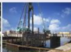
用途: 工事用仮橋 橋長・幅員: 14m x 20m 発注者: 川口市 施工地: 埼玉県川口市
