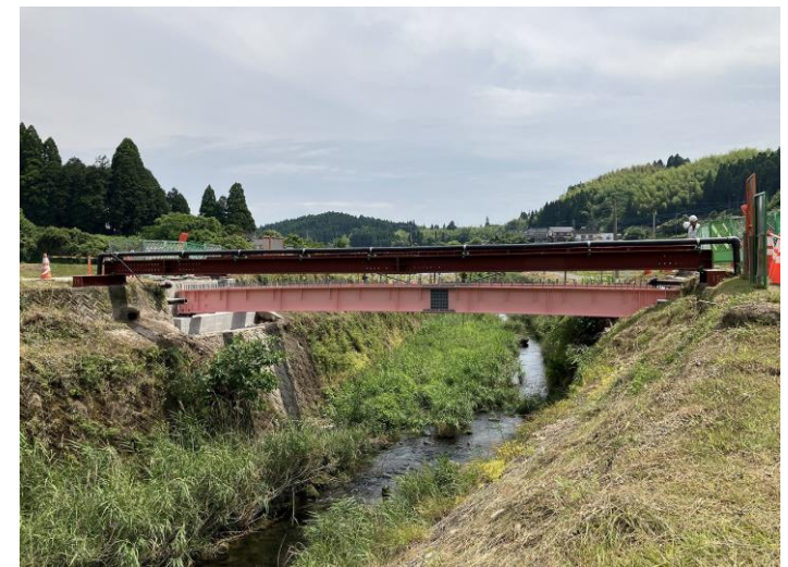
対象橋梁(山ノ口橋)全景
