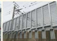
■ 防風フェンス
