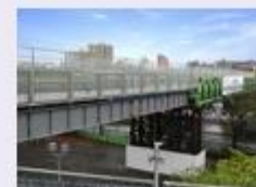
用途: 歩道用仮橋 橋長・幅員: 54m x 4m 発注者: 東京都 施工地: 東京都調布市
