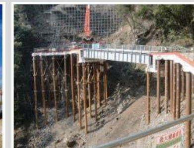
地すべり地帯迂回路仮橋(徳島県)
