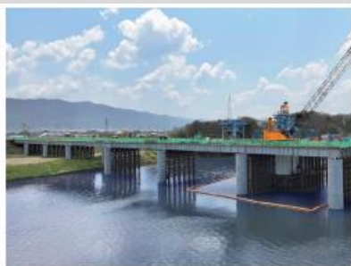
架替工事用仮橋(福岡県)
