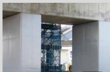
耐震補強鋼板
