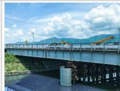
架替用迂回路仮橋(京都府)
