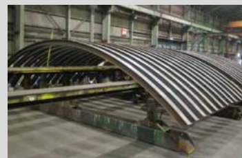
トンネル支保工
