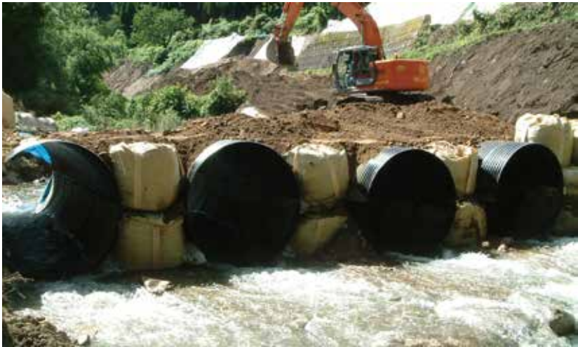
円形パイプ施工状況
