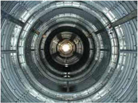
引き出しトンネル内部(設備設置前)
