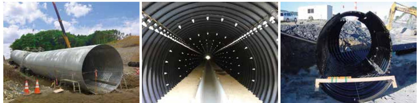
円形2形の施工状況
