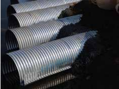
仮設工事用道路の排水路での設置状況
