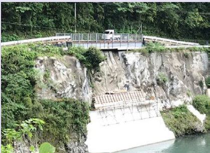
用途: 災害時応急橋 橋長・幅員: 18m x 3m 発注者: 徳島県 施工地: 徳島県海陽町
