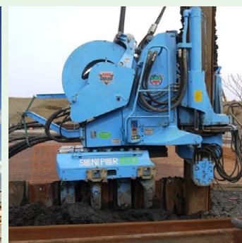
サイレントパイラー工法
