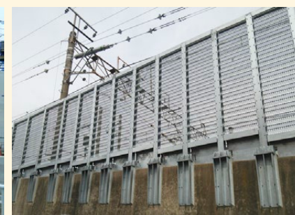
防風フェンス
