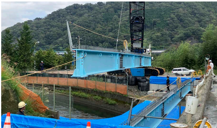
桁架設工
