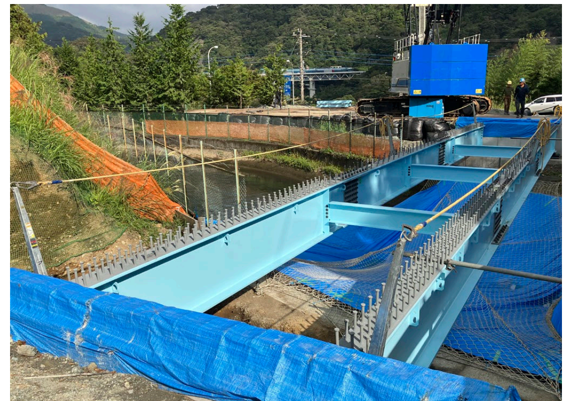
桁架設完了
