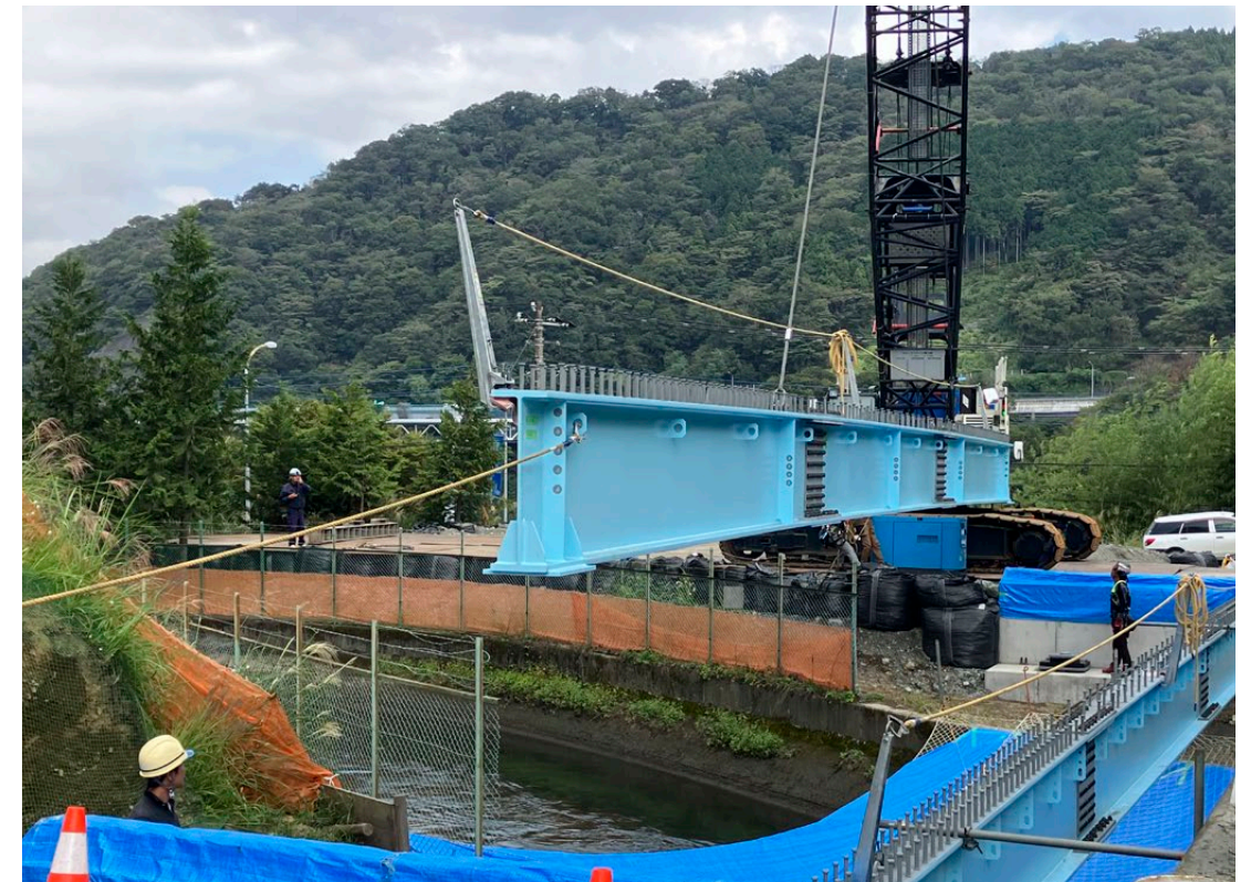
桁架設工
