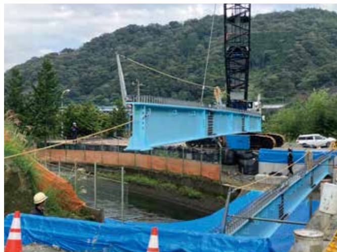
H形鋼橋梁 GHB 桁架設
