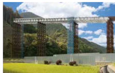
山岳トンネル進入路仮橋
