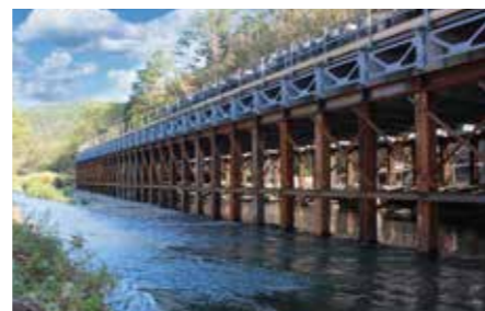
河川横断作業ヤード
