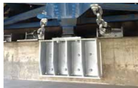
落橋防止金物
