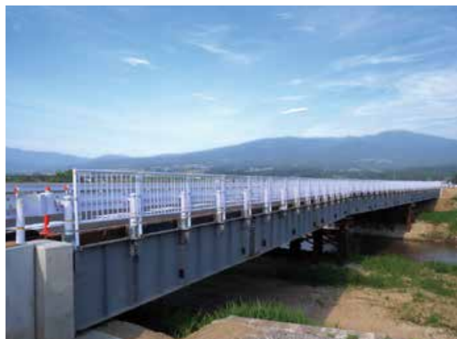
架替用迂回路仮橋
