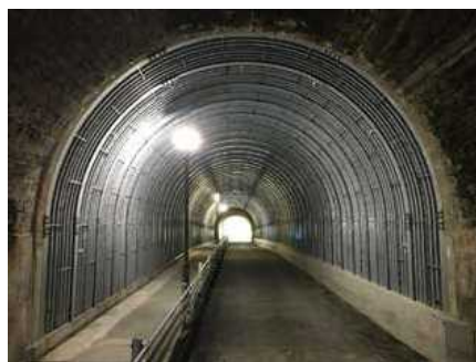
施工事例写真
