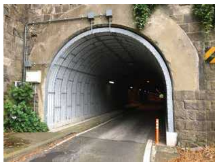
施工事例写真
