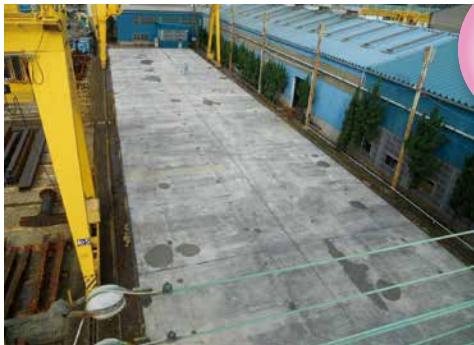
仮組ヤード 長さ78m × 幅17m
