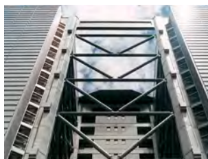
二重鋼管座屈補剛ブレース 施工例
