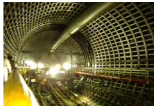
鋼製セグメント 施工状況
