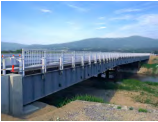
仮設橋梁 施工実績
