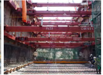
Ecoラム® 工法 道路両渠工事
