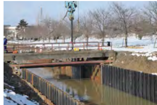
軽量鋼矢板による水路
