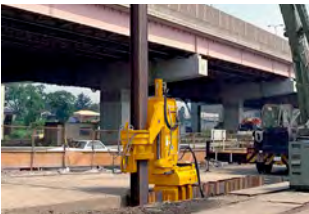
Jドーム® 施工状況
