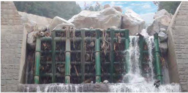
J-スリット® 堰堤による土石流補足
