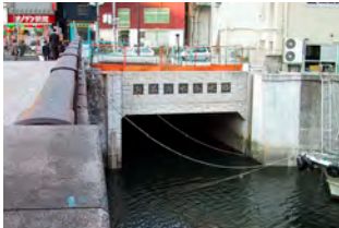
Jドメール® 分水路施工例
