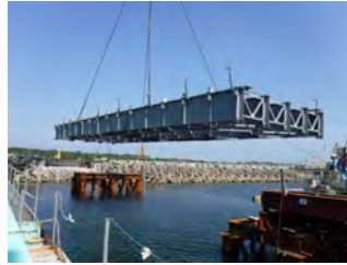
仮設橋梁 施工状況
