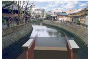
Jドメール® による河川改修
