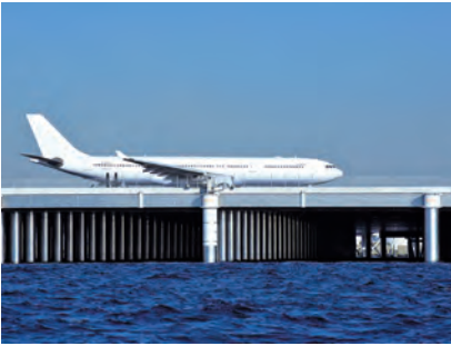
ジャケット工法 施工事例
