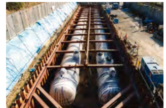
飲料水兼用耐震性貯水槽 施工事例
