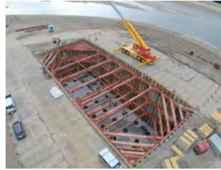
Ecoラム® 工法 橋脚基礎工事
