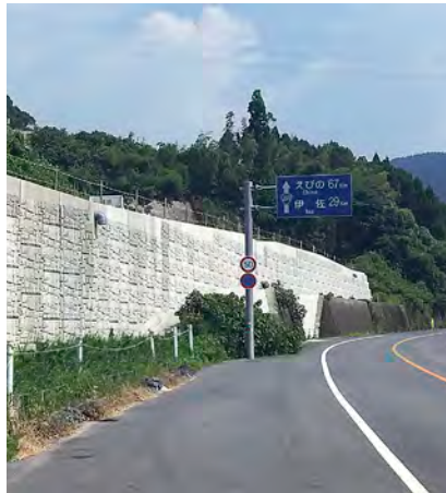
テールアルメ FS 施工例
