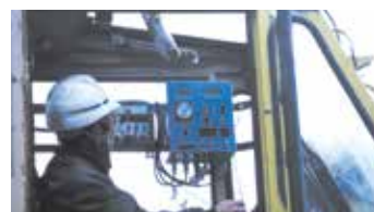
施工管理計の例
