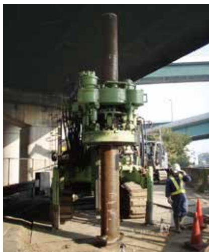
低空頭・狭隘地施工
