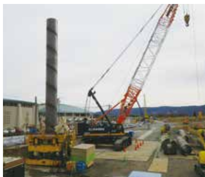
全周回転機による施工
