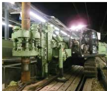
軌道内施工、機械式継手
