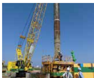
ヤットコ挿入状況
