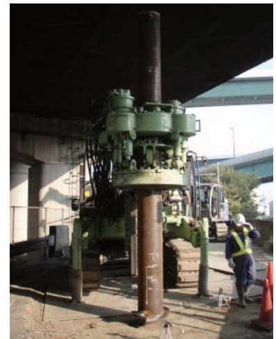
低空頭・狭隘地施工
