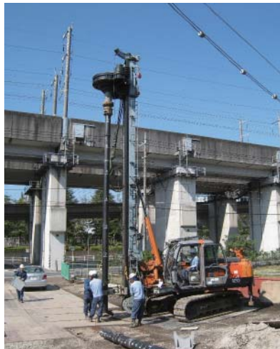
小径杭の施工状況
