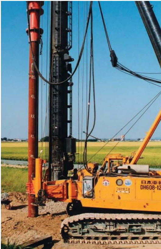
施工状況(クローラ式杭打機)
