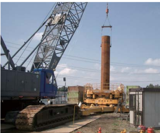
施工状況(全周回転機)
