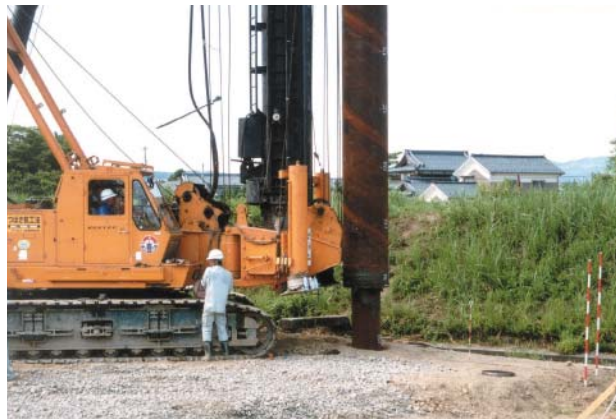
拡頭杭の施工
