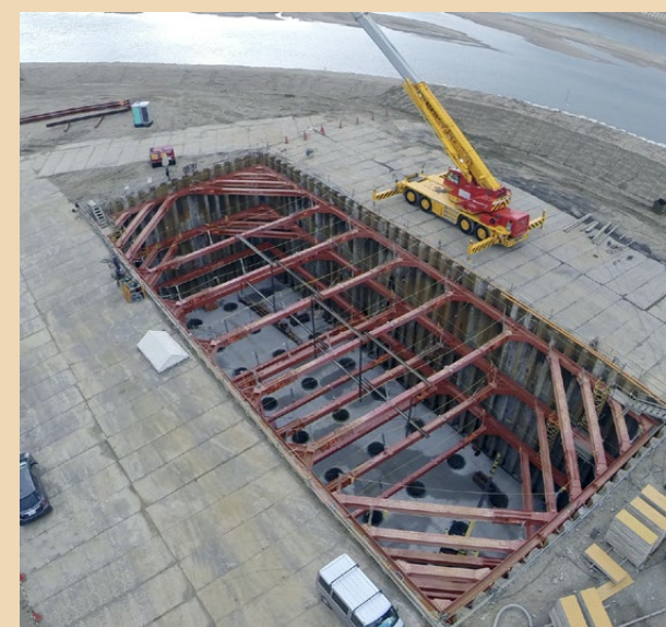
橋脚新設工事
