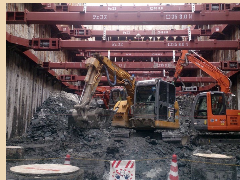
道路函渠工事
