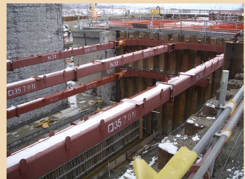
頭首工改修工事
